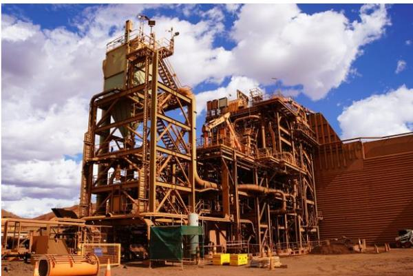
Abbildung 18: Vorbrecher an einer SKW-Kippstelle
