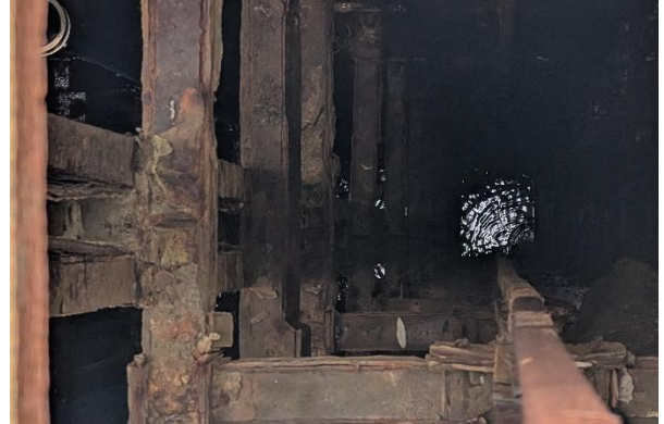
Blick in einen alten Schacht, aus welchem heutzutage Wasser abgepumpt wird
