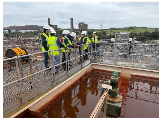
Begehung der Aufbereitungsanlage, unten rechts ein Setzbecken mit Lamellenklärer, im Hintergrund sind die typischen Ruinen des ehemaligen Abbaus zu sehen
