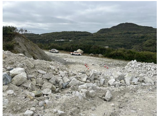
Probesprengung im Lagerstättenbereich und Blick vom gesprengten Gestein auf den Rest des Tagebaus
